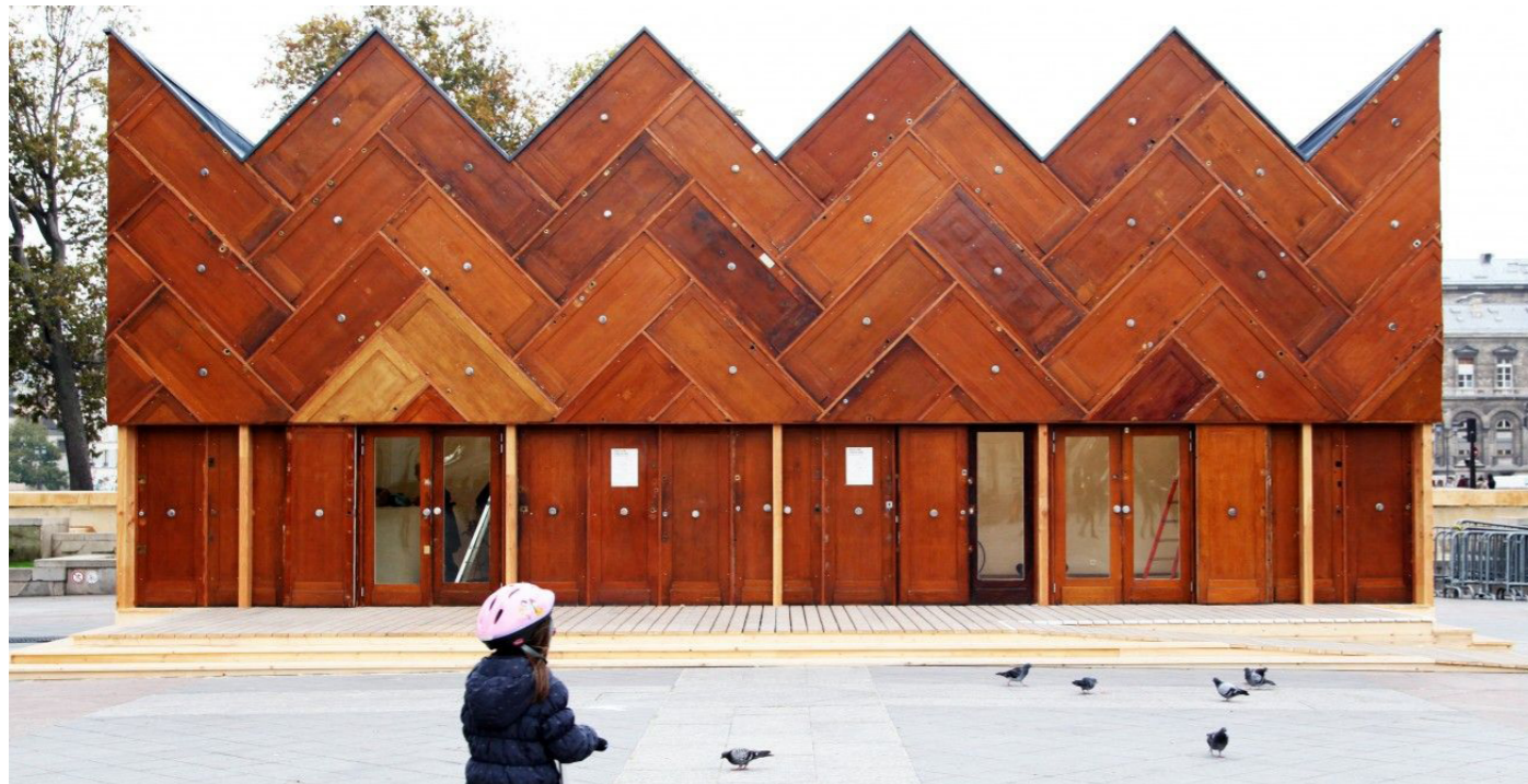
©Encore Heureux architectes 2015 - Pavillon circulaire, Paris
