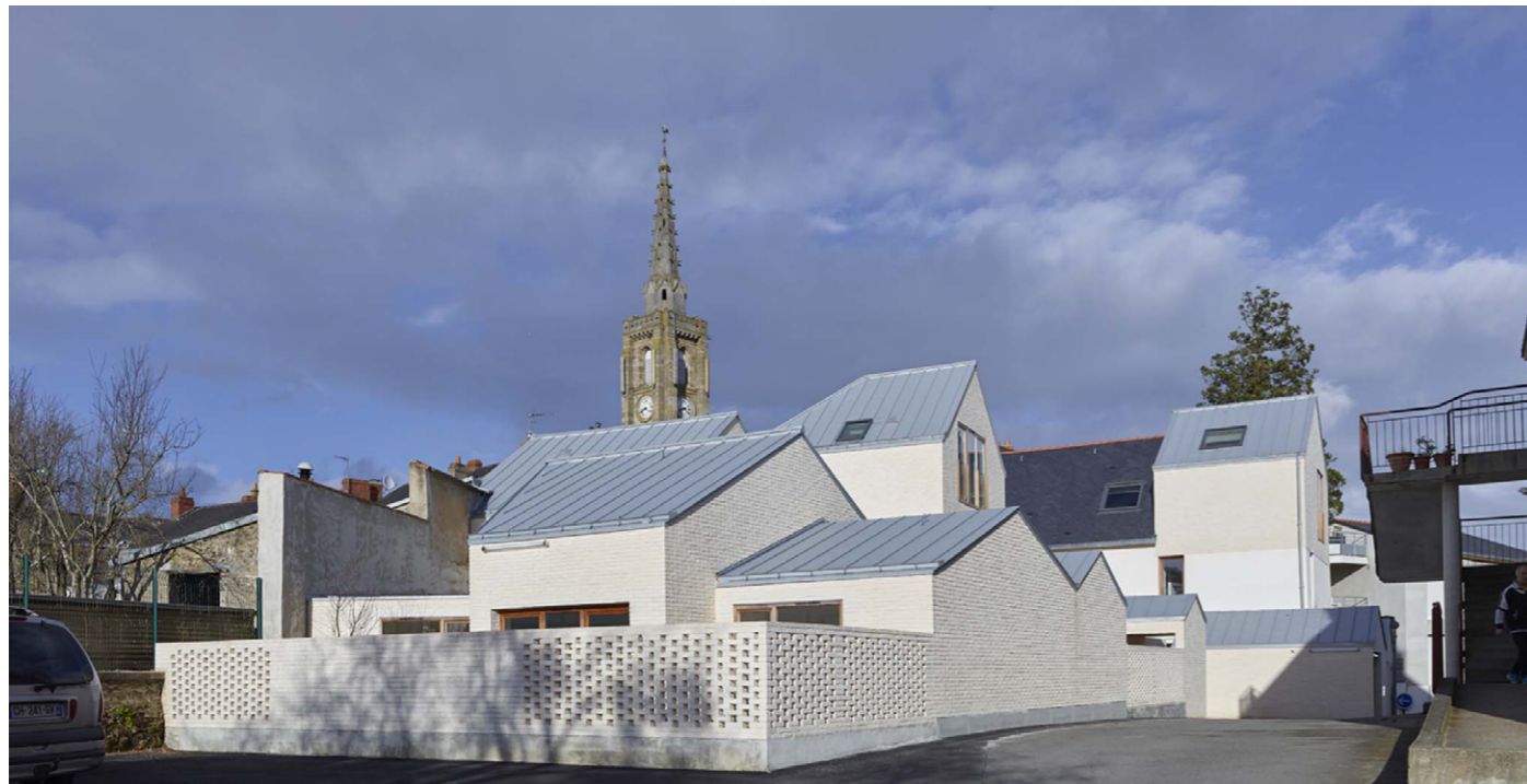
©S. Chalmeau 2016 - 6 logements locatifs, Mauves-sur-Loire
