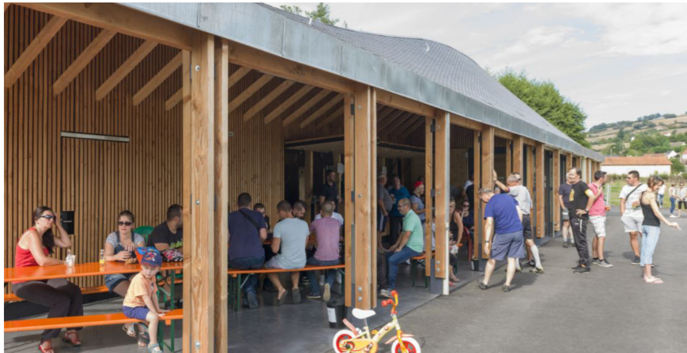
©Kefir/AMD Architectes-Ingénieurs 2016 - Salle du Chambon, Marmagne (71)
